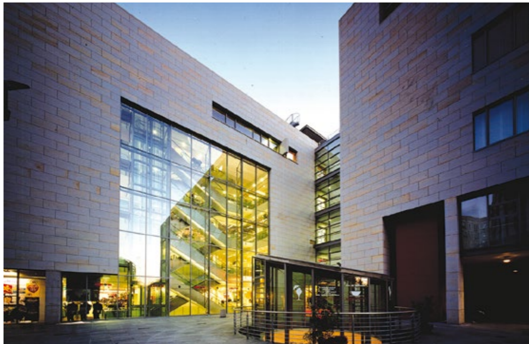
COTTAER SANDSTEIN-gwg- Kaufhaus Wöhrl, Prager Straße Dresden
