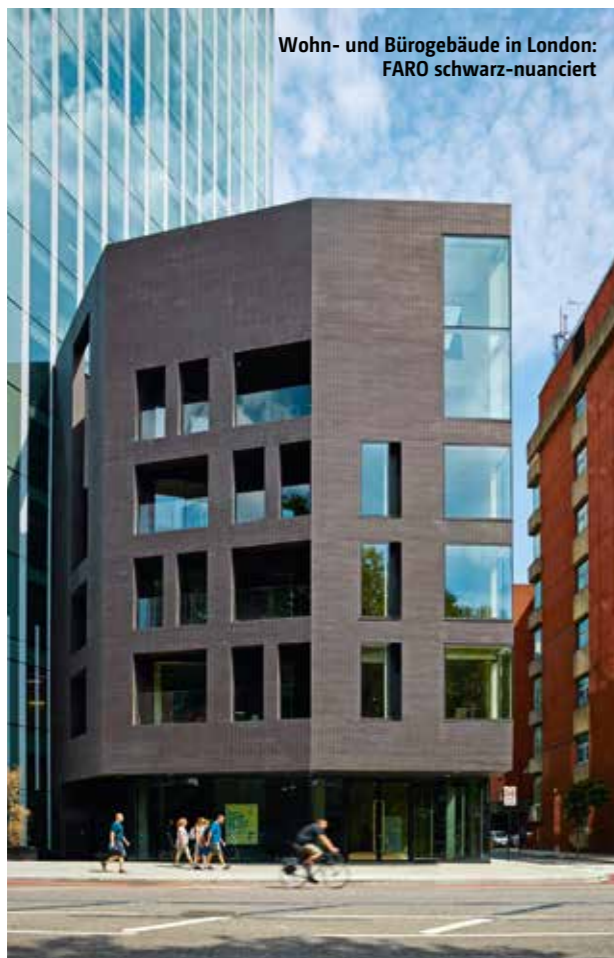
Standard-Läuferwinkel für den Sturz-Bereich. Aber in der Fassade müssen es nicht immer rechte Winkel sein.
