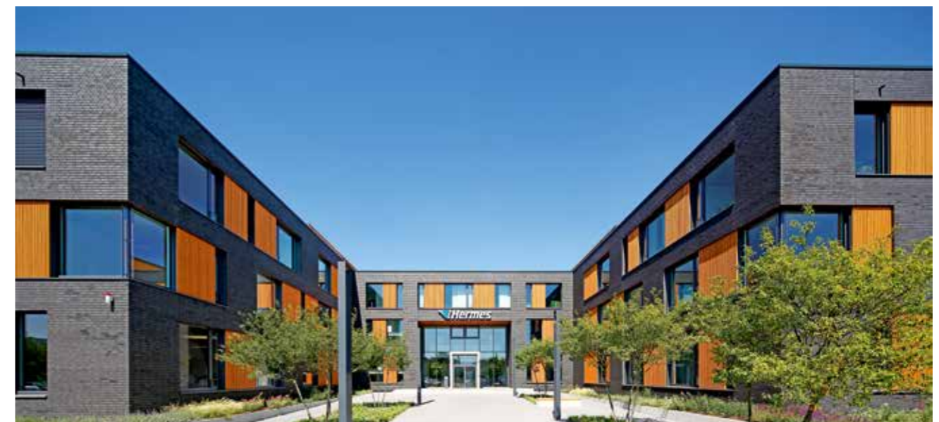
Dunkle Klinkerriemchen auf WDVS sind bauphysikalisch unproblematisch: SYDNEY
