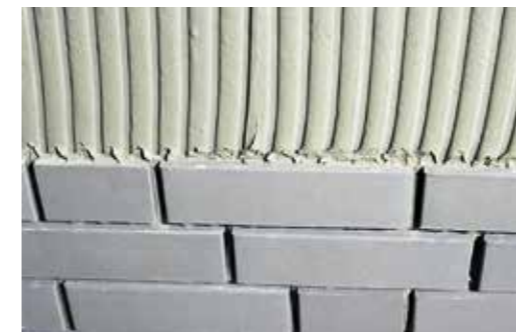
Die Riemchen sind vollständig in den Kleber eingebettet
