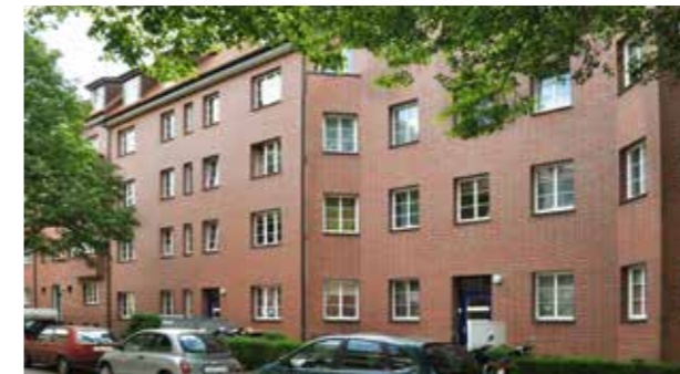
Unter Bestandsschutz stehende Wohnquartiere werden mit optisch passenden WESTERWALD bunt Klinkerriemchen-WDVS saniert.
