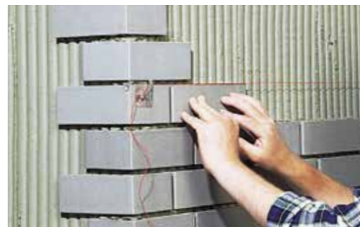
Setzen der Flächenriemchen mit Hilfe einer Schnur
