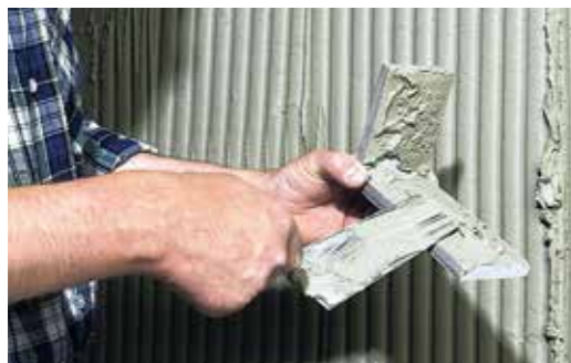
Kleberauftrag im kombinierten Verfahren („Floating-Buttering“)
