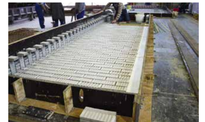
Die Riemchen werden im Röben-Werk zum Betonieren vorbereitet.
