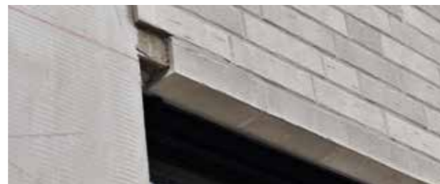
Standard-Läuferwinkel für den Sturz-Bereich. Aber in der Fassade müssen es nicht immer rechte Winkel sein.
