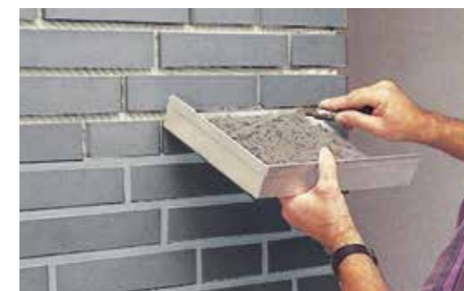
Sauberes Verfugen mit Fugeisen und Fugblech
