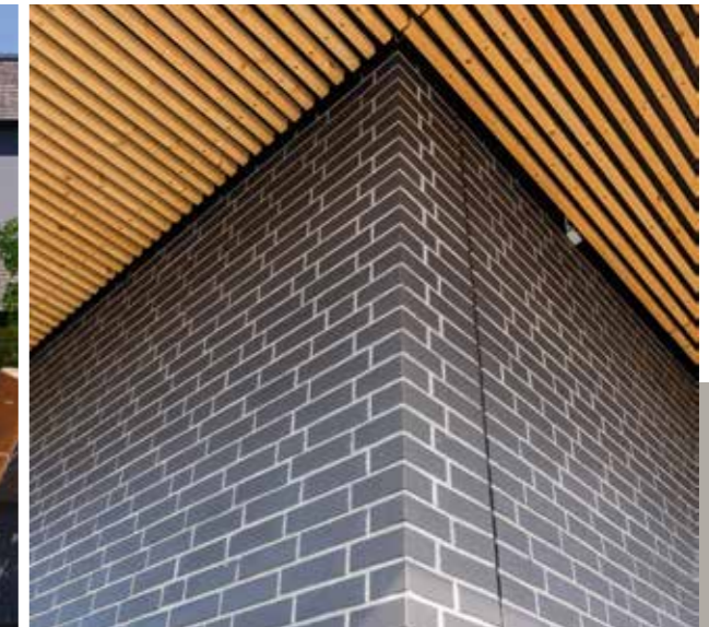
Hier nimmt die Dehnungsfuge die Bewegungsspannungen der Riemchenbekleidung im Eckbereich auf, FARO schwarz-nuanciert
