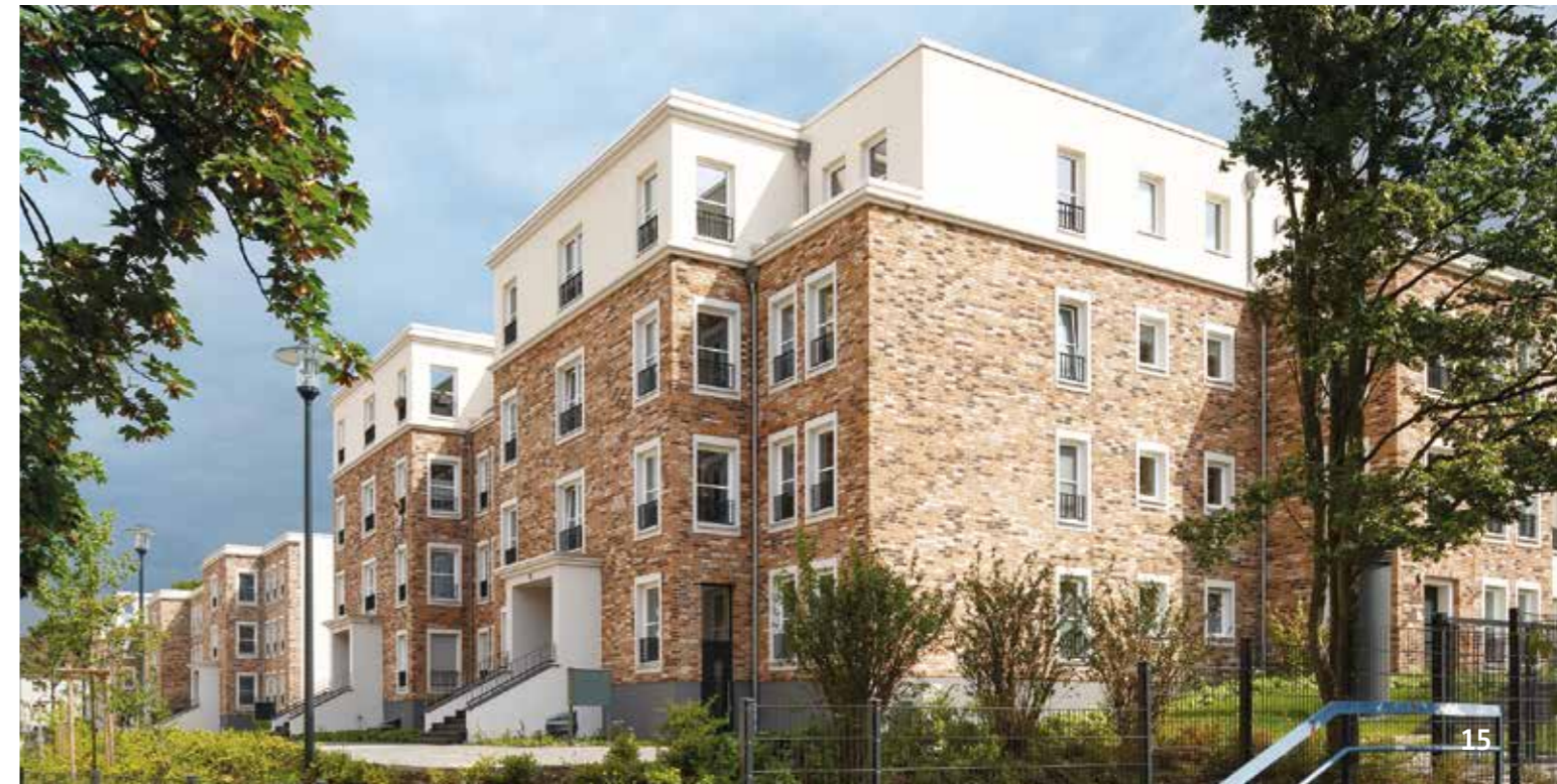
Coole Rustikalität: Wohnanlage in Hagen mit Handform-Riemchen MOORBRAND torf-bunt
