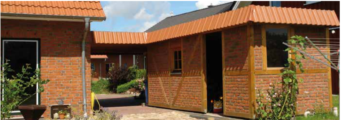
Stimmungsvolle Fachwerkkonstruktion, bauseits ausgemauert
