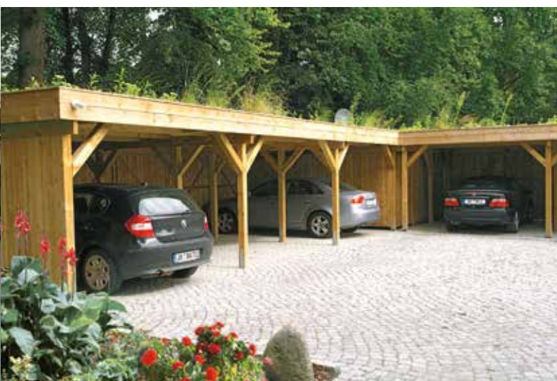
Raffinierte Idee mit grünem Pflanzenteppich: Die versiegelte Bodenfläche wird einfach auf das Dach der Reihenanlage verlegt
