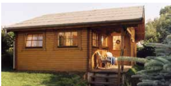
Seitenansicht „Holnis“ mit kleiner Treppe zum „Freisitz“ (bauseits)
