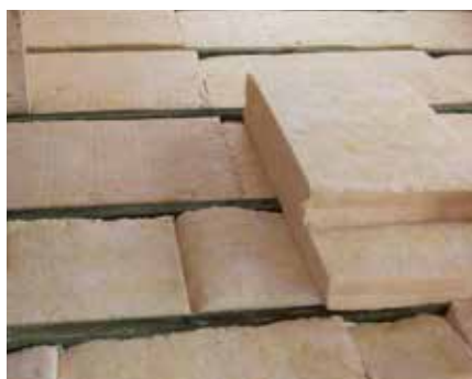
Bei Blindboden, vorbereitet für Dämmung. Machen Sie das Haus von unten winterfest
