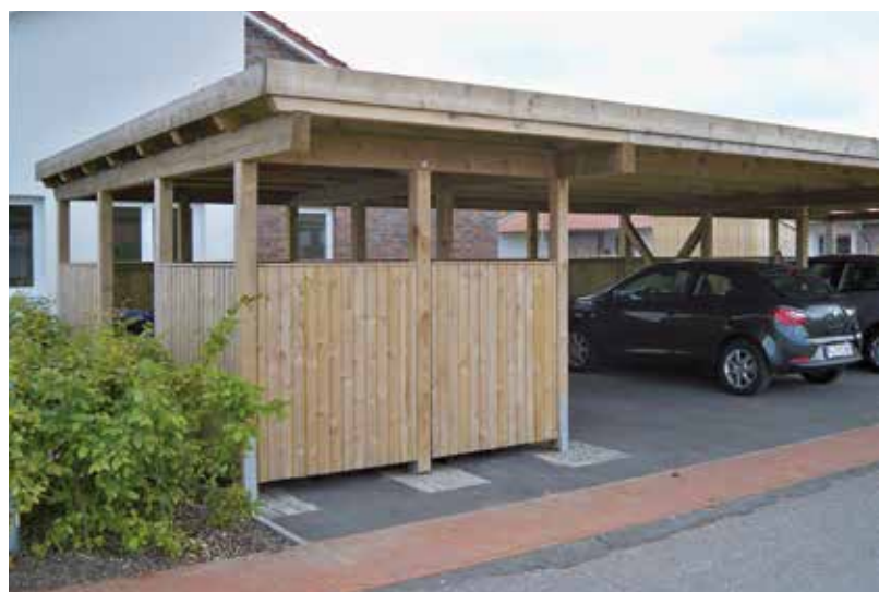
Integrierte Müllplatz-Lösung unter klassischer Stellplatz-Anlage
